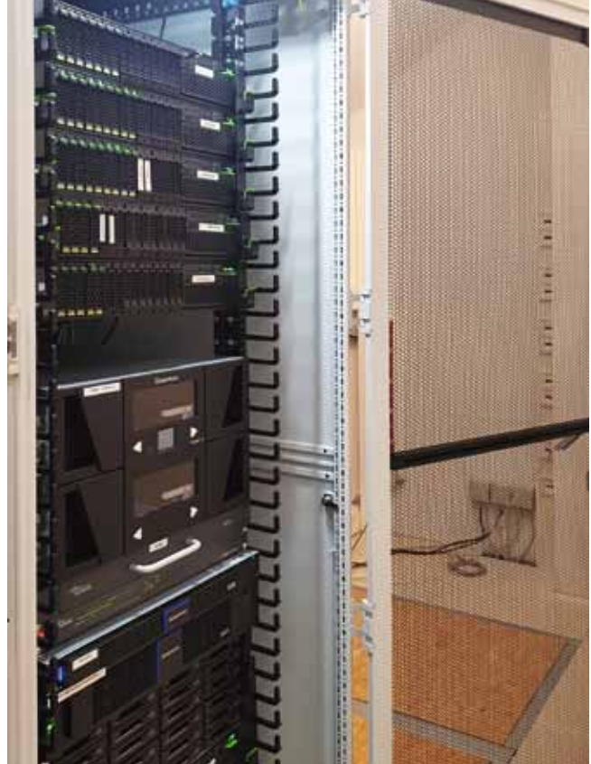
Ansicht der Tape Library im Serverschrank
