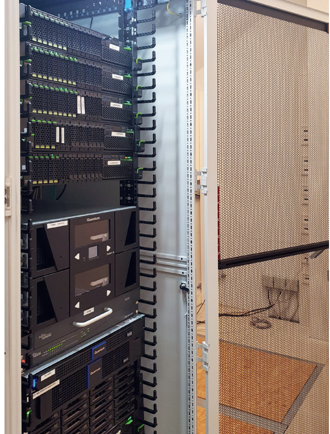
Ansicht der Tape Library im Serverschrank
