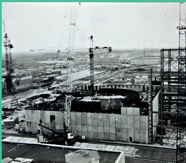
Baustelle des zweiten Reaktorgebäudes des Kernkraftwerkes Stendal bei der Montage des ersten Ringes des Containments im Jahr 1989 (LASA, I 119 VEB Kernkraftwerk Stendal, Nr. 686)
