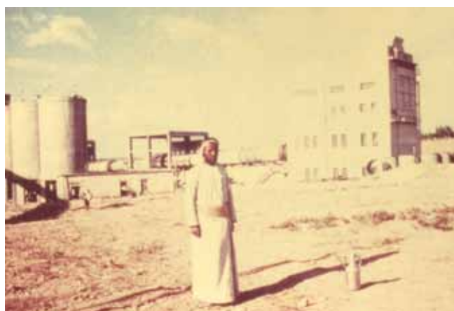
Arbeiter vor der Zementfabrik in Aleppo / Syrien, ca. 1960 (I 420, Nr. 721 F 1)
