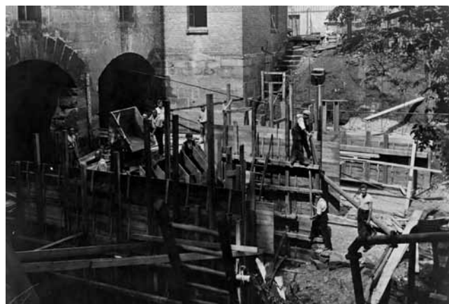
Bauarbeiten an der Marienmühle, Weißenfels (1927)
