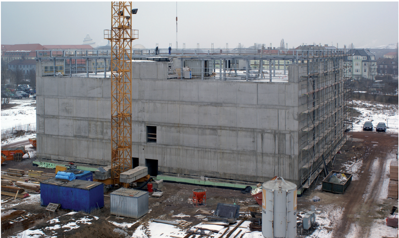
Das Magdeburger Magazin in der Bauphase
