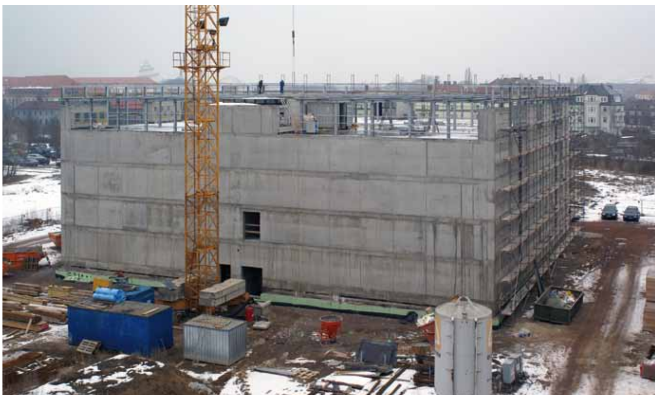
Das Magdeburger Magazin in der Bauphase
